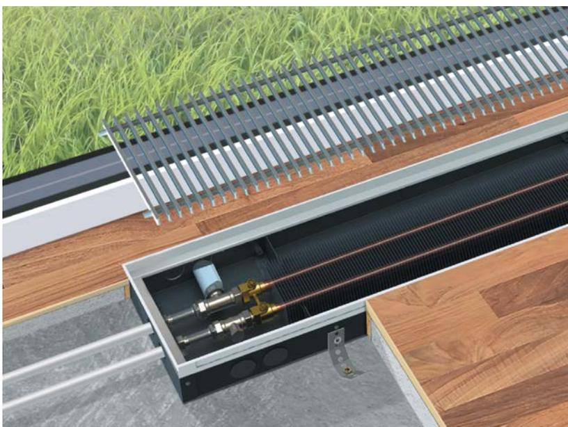
Установить нагревательный элемент в корпусе в соответствии с подводкой труб.
