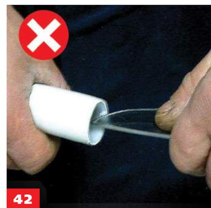
Не допускается снимать фаску с помощью ножа
