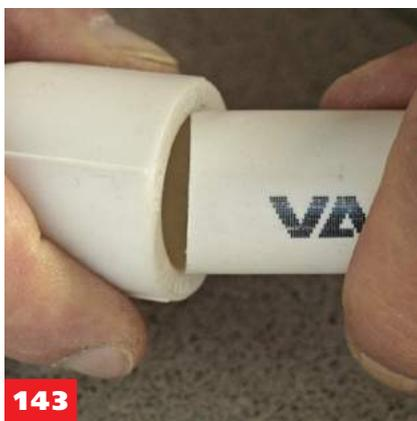
143 До выполнения соединения следует проверить качество трубы и фитинга. Для этого надо попробовать ввести трубу в гнездо фитинга. Труба в него не должна входить. Если труба свободно входит в гнездо, то качественного сварного соединения не получится.
