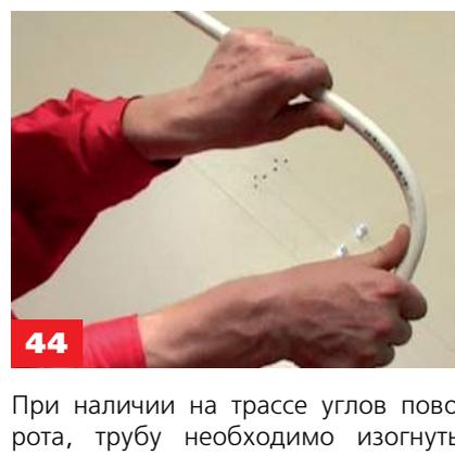
При наличии на трассе углов поворота, трубу необходимо изогнуть, придав ей проектный радиус изгиба. Вручную допускается изгибать трубы диаметром 16 и 20 мм, при этом радиус изгиба должен составлять не менее 80 и 100 мм. Для облегчения придания трубе заданного радиуса изгиба удобнее использовать выполненный из мягкой проволоки шаблон
