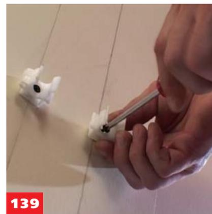
139 Разметка трассы трубопровода и установка подвижных и неподвижных опор производятся в том же порядке, как и для металлополимерных труб.
