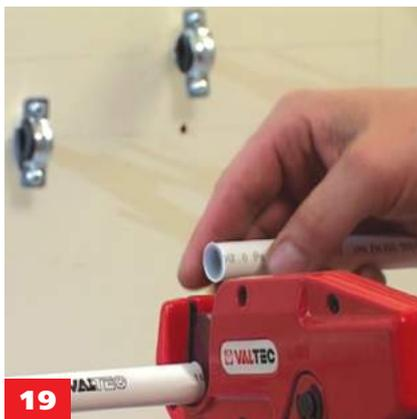
19 - производится разрезание трубы, для чего рукоятка трубо-реза многократно нажимается до упора, придавая ножу поступательное движение;
