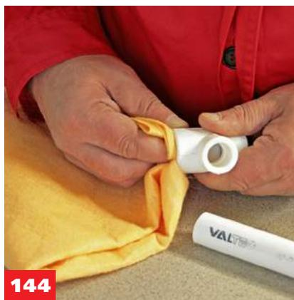
144 В случае, если край трубы и гнездо фитинга сильно загрязнены, необходимо перед сваркой их тщательно протереть ветошью. Особенно опасно наличие на свариваемых поверхностях машинного масла и жиров.
